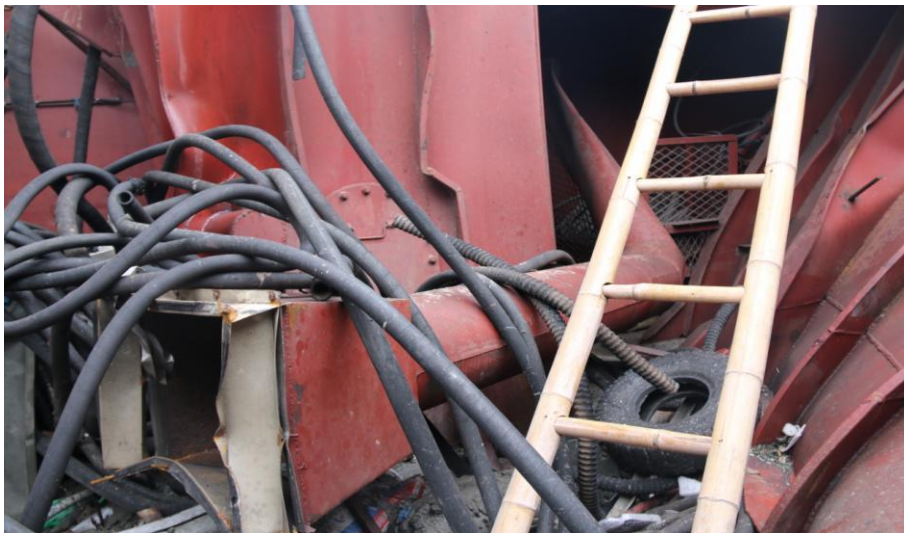
图 5：除气系统通风筒
