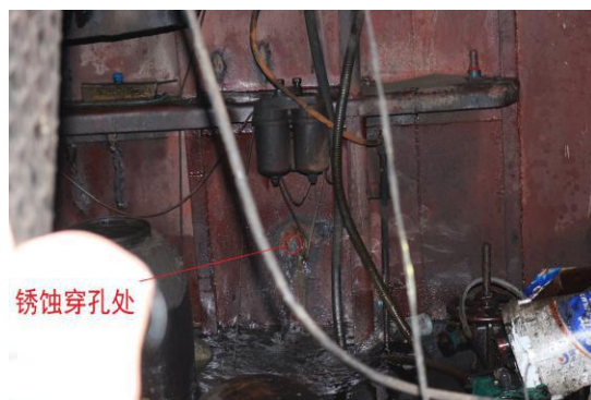
图 5：锈蚀穿孔标记
